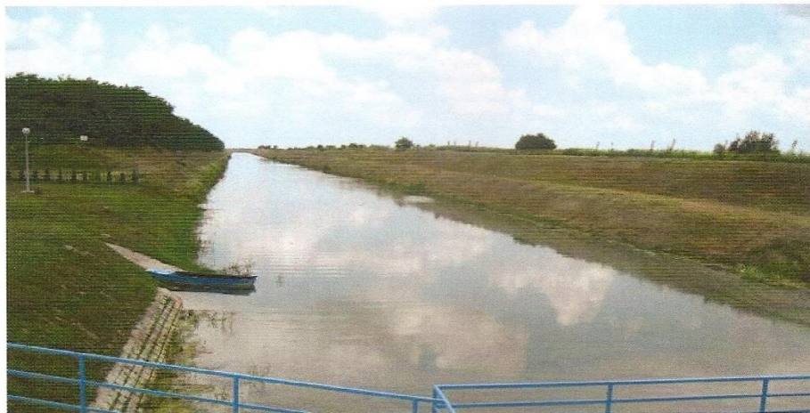
CS Dvor - dovodni kanal
