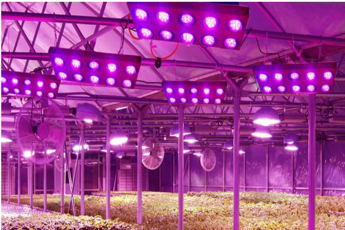
Slika 15. LED osvjetljenje u proizvodnji presadnica (Izvor: https://www.google.hr/search?q=led+lamps+for+growing&rlz )
