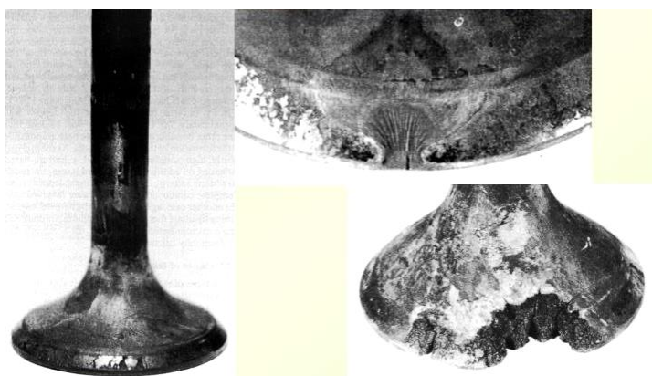
Slika 4. Oštećenja sjedišta ventila zbog kemijske korozije (Medica, 2010.)
