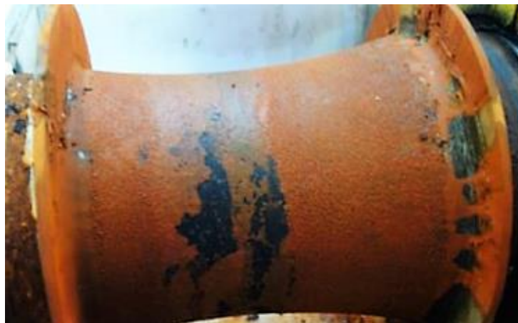
Slika 17. Korozijski zamor dijela osovine
