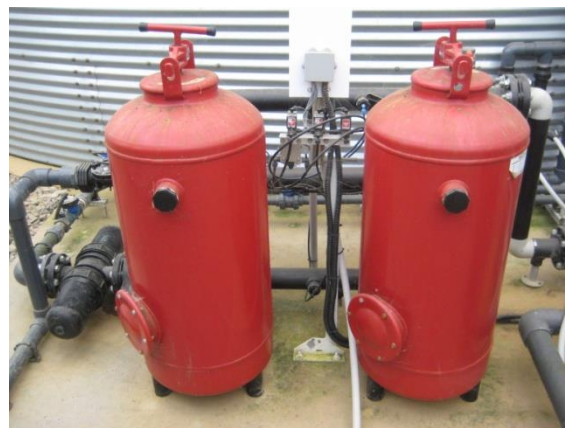
Slika 22. Pješčani filteri (Fotografija: Šarlija K., 2016.)
