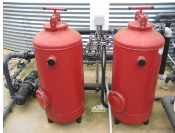
Slika 22. Pješčani filteri (Fotografija: Šarlija K., 2016.)
