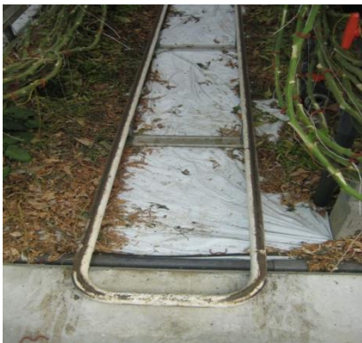
Slika 31. Grijaće cijevi (Fotografija: Šarlija K., 2016.)
