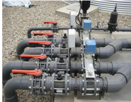
Slika 24. Jedinice za navodnjavanje (Fotografija: Šarlija K., 2016.)
