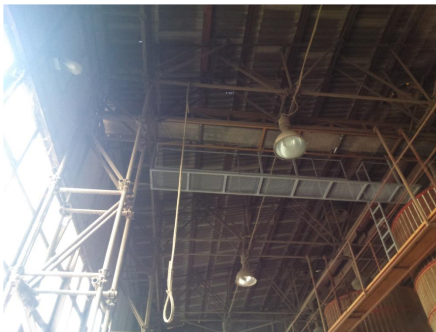
Slika 7. Traka od elevatora do trake koja raspoređuje klip u koševima (vlastita fotografija)
