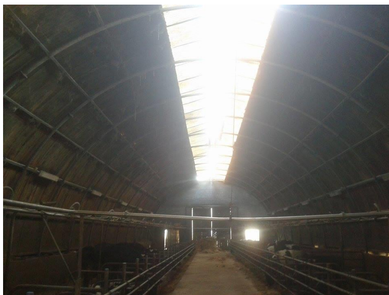
Slika 13. Primjer vertikalne ventilacije staje (Izvor: www.poljoprivredniforum.com )
