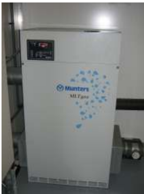
Slika 31. Dehumidifikator Munters MLT 800. Autorska fotografija.
