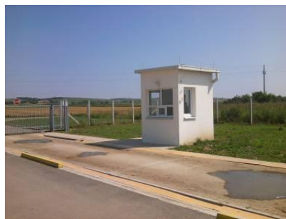
Slika 14. Vagarska kućica sa kolnom vagom
