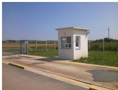
Slika 14. Vagarska kućica sa kolnom vagom
