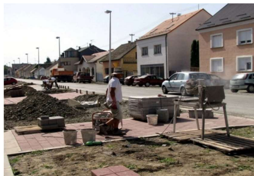
Slika 24. Rekonstrukcija Pavićeve ulice 2012. g.
