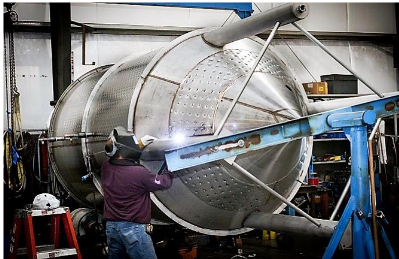
Slika 25. Popravak nehrđajućeg spremnika hrane za stoku
