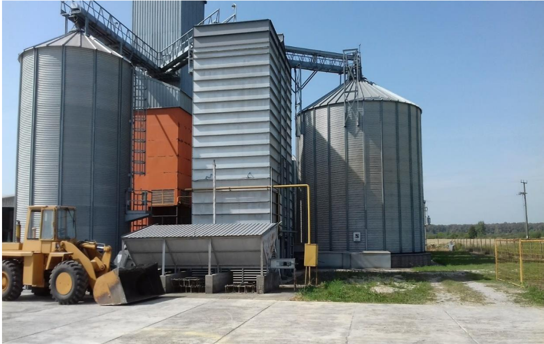
Slika 4. Silos u Drenovcima (850 t) (Foto: Oliver Kandrać)
