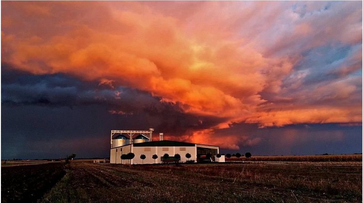
Slika 1. Skladište OPG-a Kolarić sa silosima (Izvor: Anja Kolarić)
