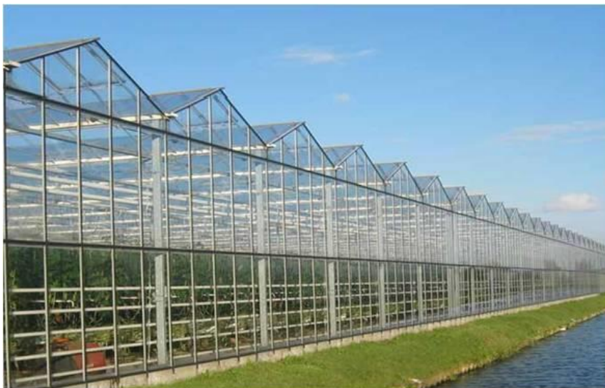
Slika 13. Konstrukcijski povezani brodovi staklenika
