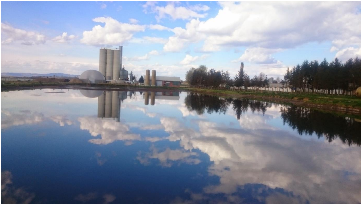
Slika 8. Laguna sa tekućim digestatom- Bioplinsko postrojenje Gradec
