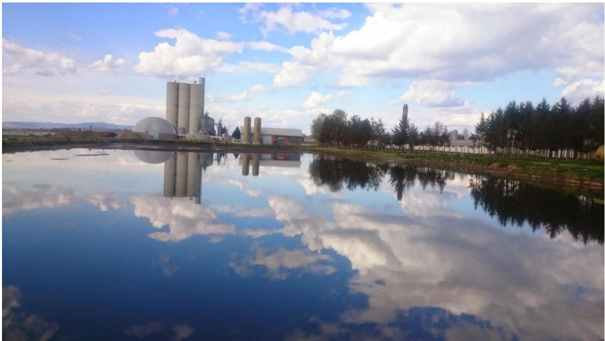
Slika 8. Laguna sa tekućim digestatom- Bioplinsko postrojenje Gradec
