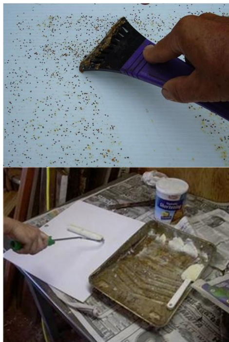
Slika 6. Čišćenje i premazivanje podloška
