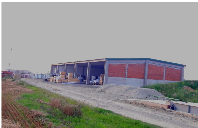
Slika 1. Objekt za skladištenje mehanizacije (izvor: Tokić, M.)
