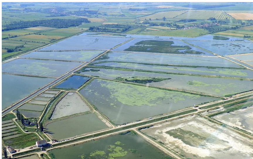
Slika 3. Toplovodno ribnjačarstvo Grudnjak
