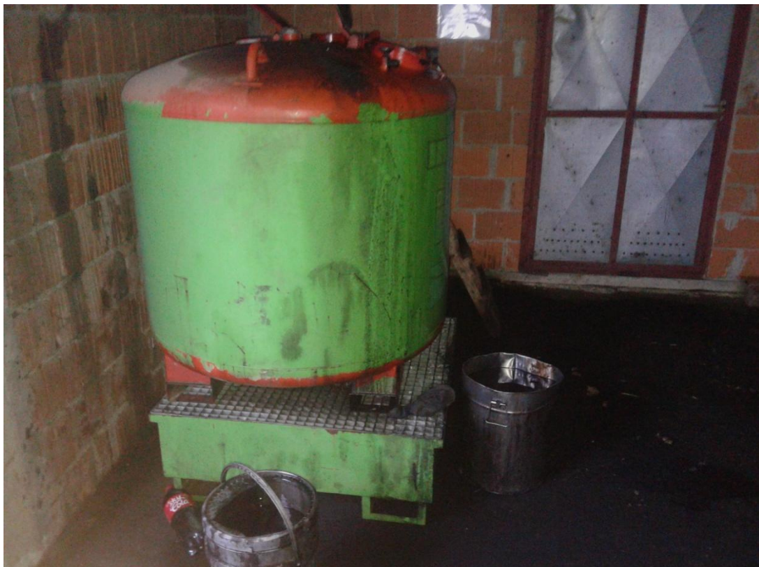
Slika 34. Spremnik za skladištenje rabljenog ulja (Izvor: vlastita fotografija)
