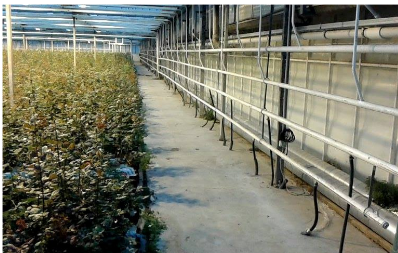
Slika 20. Cijeviza grijanje staklenika na bočnim stranama
