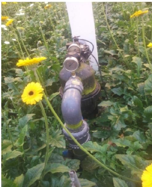
Slika 11. Visokotlačna crpka
