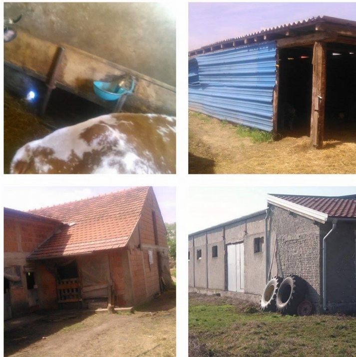
Slika1. Smještajni objekti na gospodarstvu
