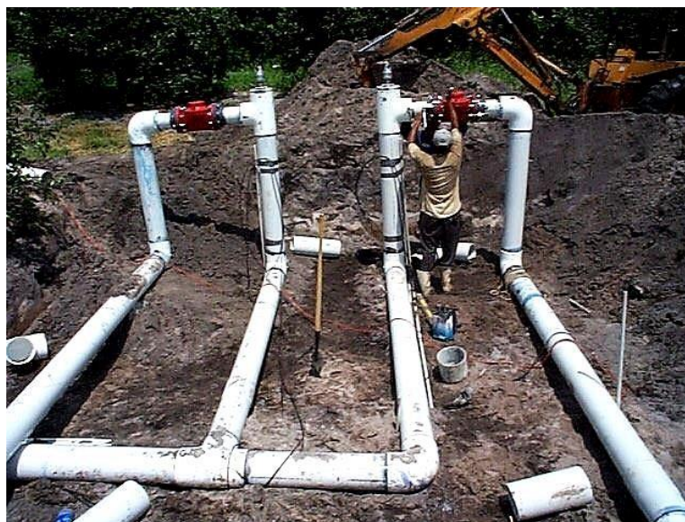
Slika 27. Ugradnja PVC cijevi za navodnjavanje plantaže agruma
