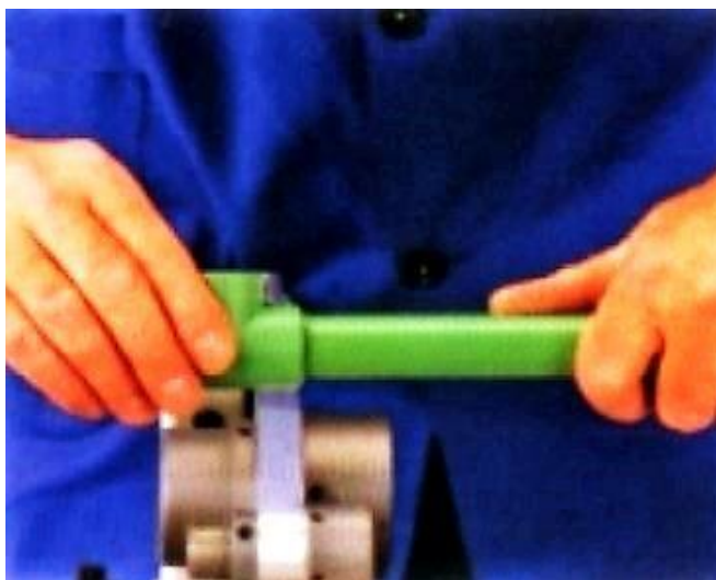
Slika 24. Zavarivanje PP-R cijevi: Utiskivanje cijevi u koljeno (Izvor: http://kalinic.info/strucni/cijevi.pdf )
