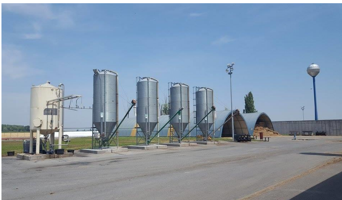
Slika 11. Vertikalni silosi za smještaj hrane
