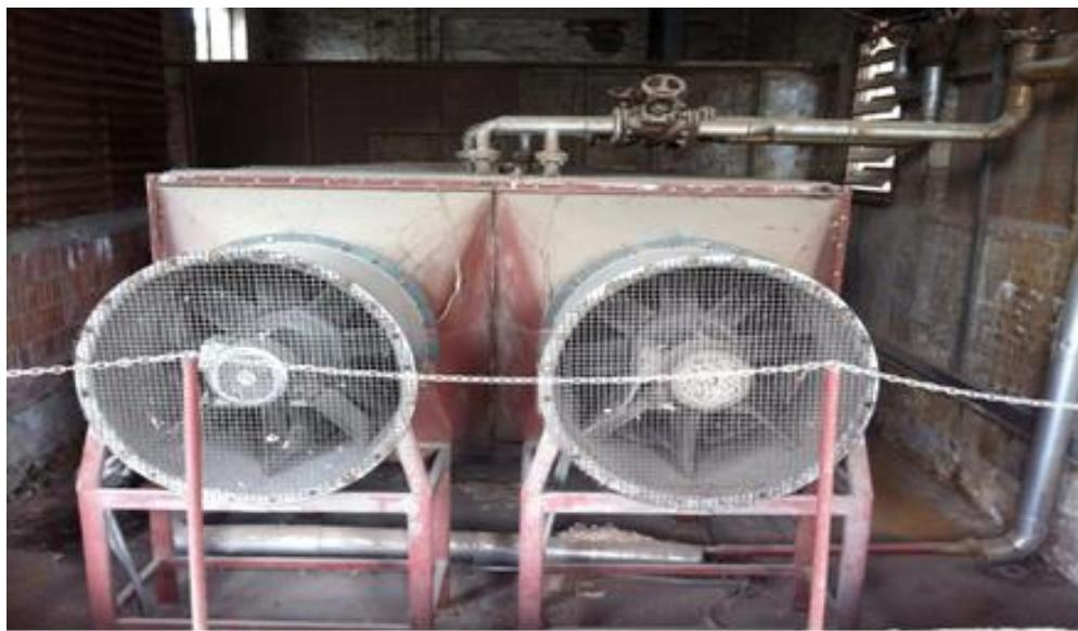
Slika 11. Ventilator i izmjenjivač topline (Izvor: vlastita fotografija)
