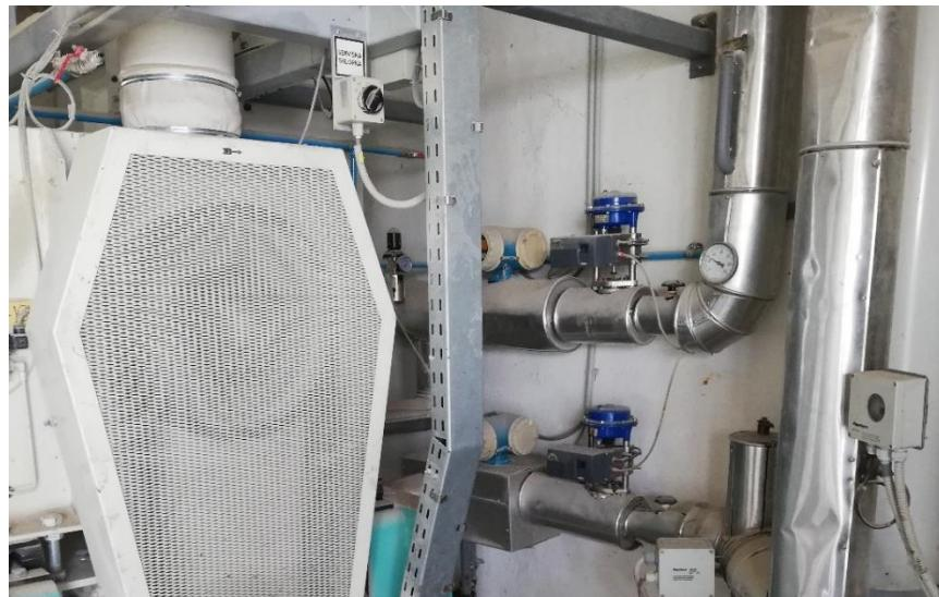
Slika 28. Cijevi za dovod tekućeg sastava smjese do homogenizatora
