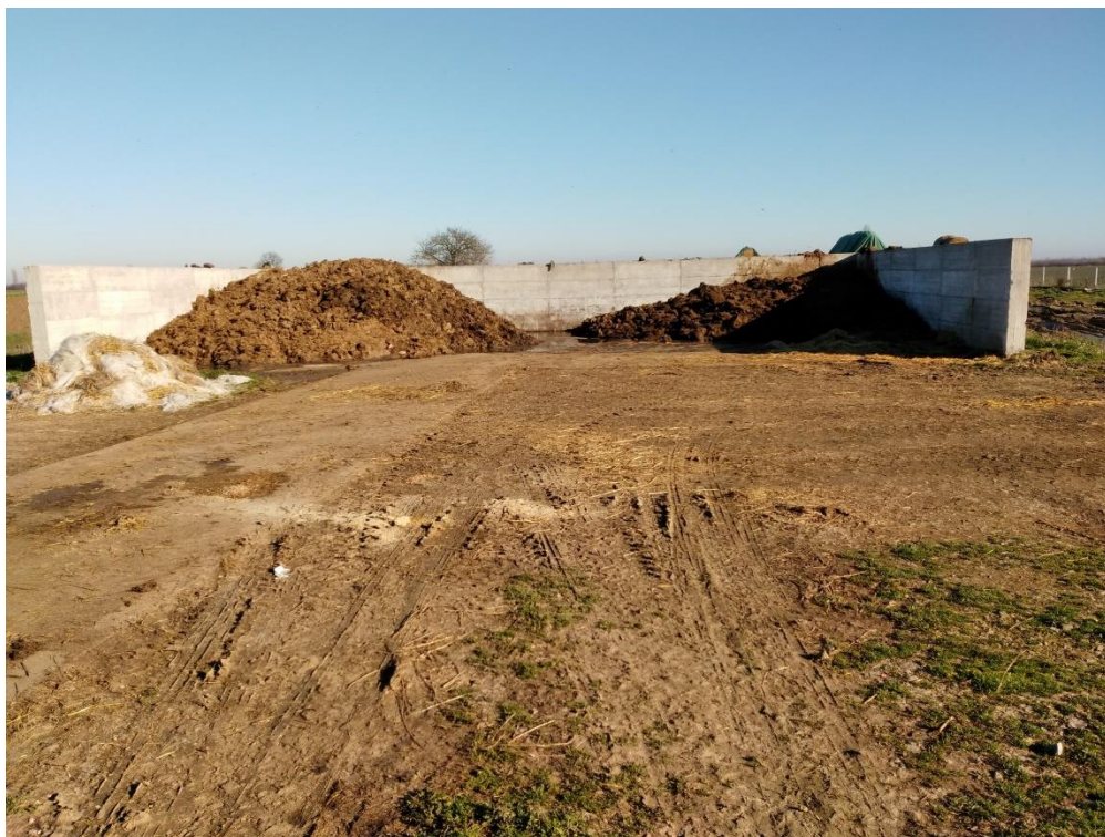
Slika 11. Betonski plato za smještaj krutog dijela stajnjaka
