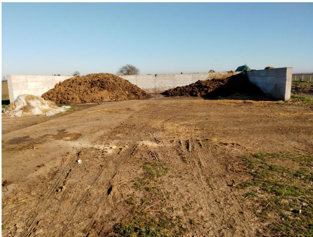
Slika 11. Betonski plato za smještaj krutog dijela stajnjaka
