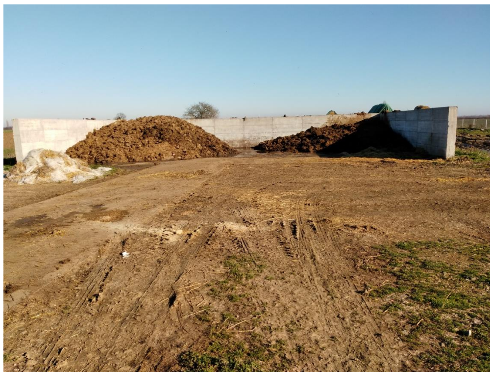
Slika 11. Betonski plato za smještaj krutog dijela stajnjaka
