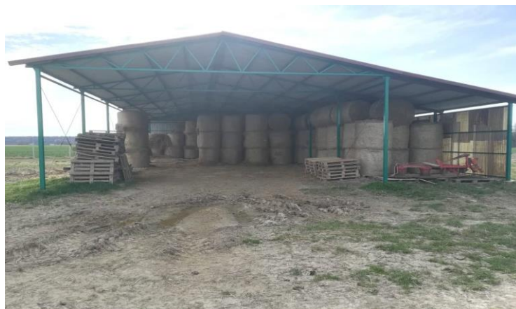
Slika 8. Nadstrešnica za skladištenje slame
