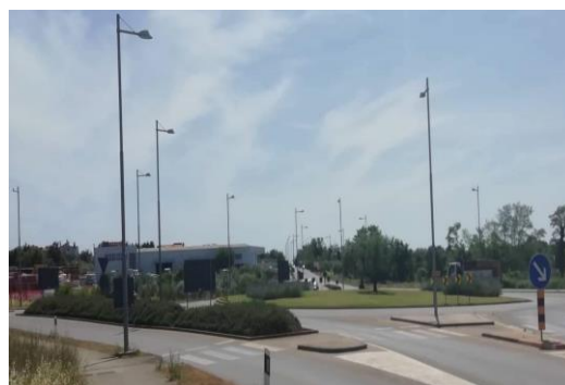
Sl. 21) Kružni tok na vanjskoj obilaznici također na sjeveroistoku grada koji predstavlja standard oblikovnosti odabirom autohtonih biljnih vrsta, stabla maslina i grmovi lavande
