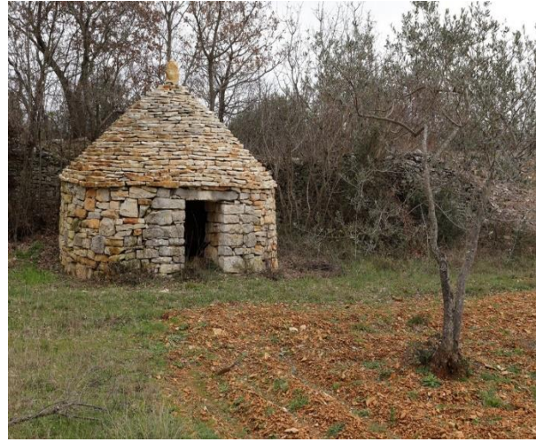
Sl.10 ) Kažun – klasične građevine za Istru, okuglastog oblika, služe za poljoprivredni alat, rađeni od prirodnog kamena
