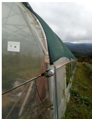
Slika 2. Elektromotor za automatsko podizanje i spuštanje bočnih strana plastenika (vlastita fotografija)
