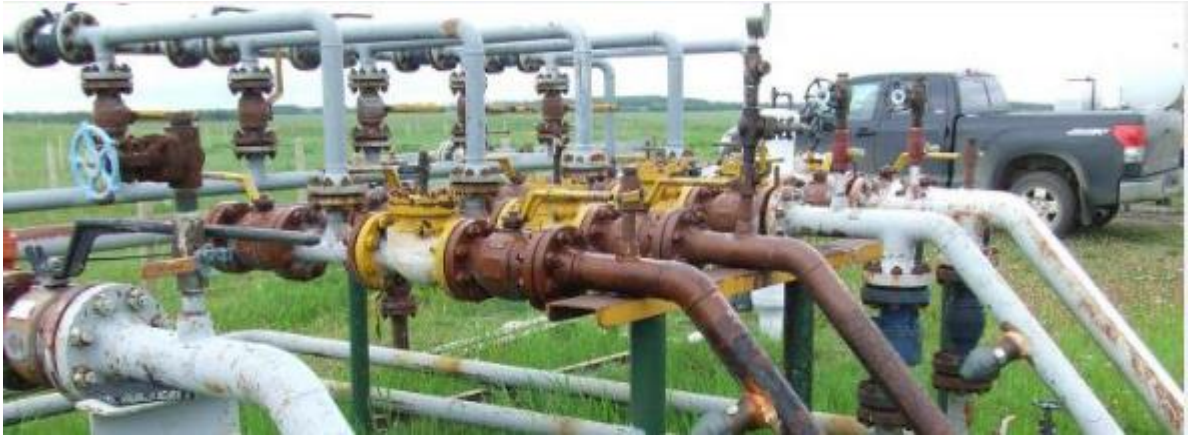
Slika 26. Korozija cjevovoda
