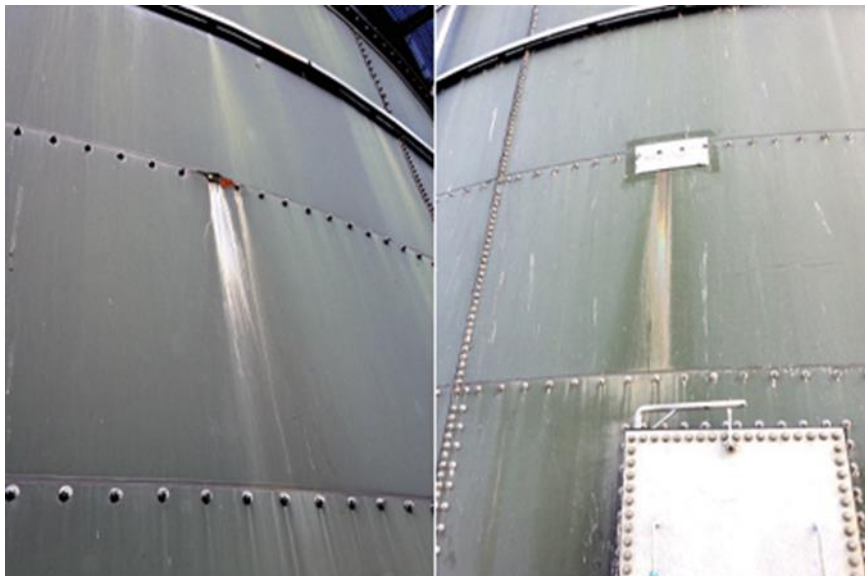
Slika 30. Oštećenje i zakrpa na čeličnom digestoru
