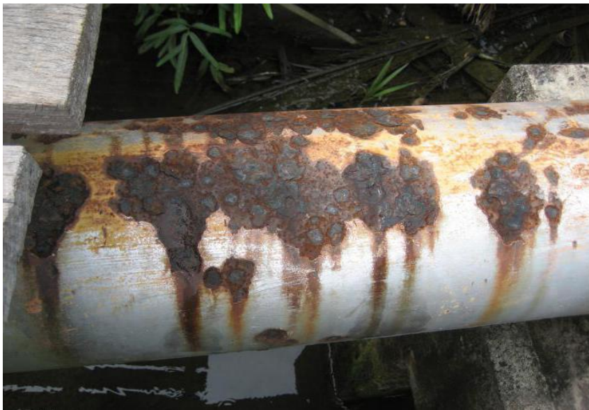
Slika 6. Korozija cjevovoda
