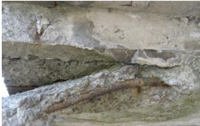
Slika 12. Korozija betona
