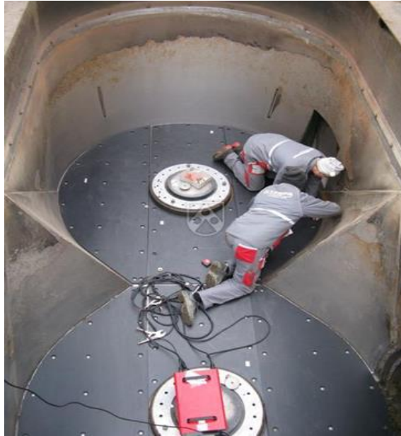
Slika 29. Postavljanje posebnih plastičnih obloga
