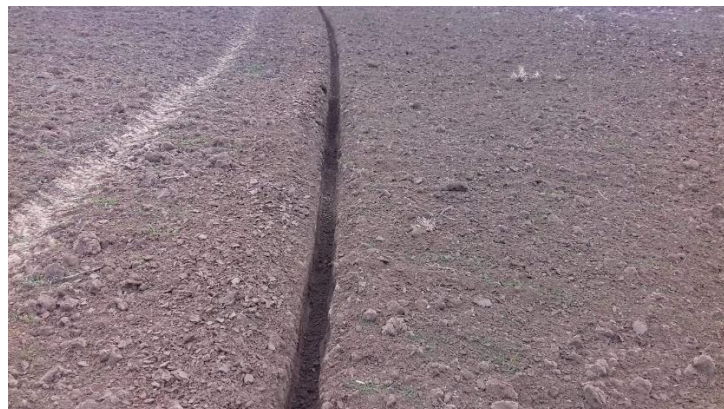
Slika 6. Kanalić za odvodnju suvišne površinske vode
