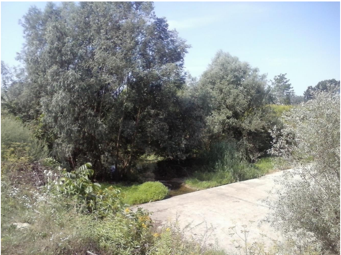
Slika 18. Prag u Gatskom kanalu(foto F.Vrbanić)
