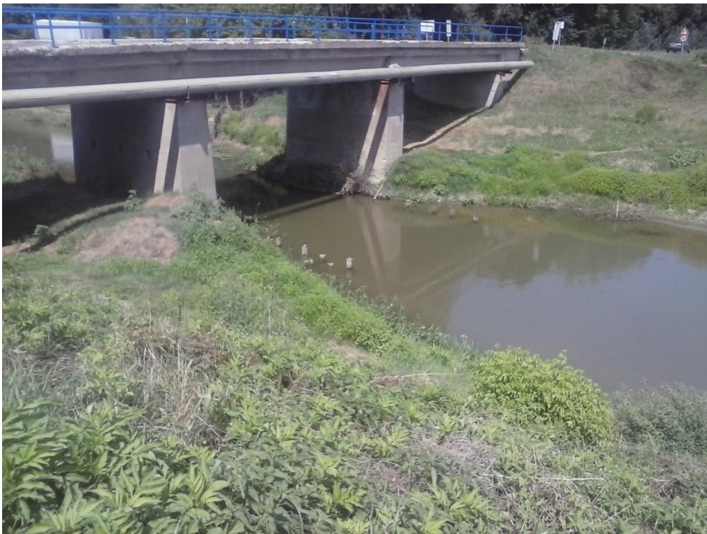
Slika 30. Most na Vučici zapadno od Ladimirevaca (foto F. Vrbanić)
