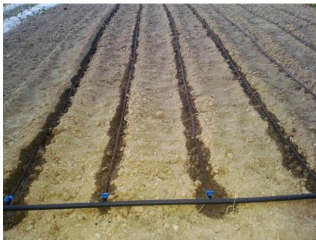
Slika 9. Raspored cijevi kod sustava navodnjavanja „kap po kap“ (izvor: https://bit.ly/2SrAMyw )
