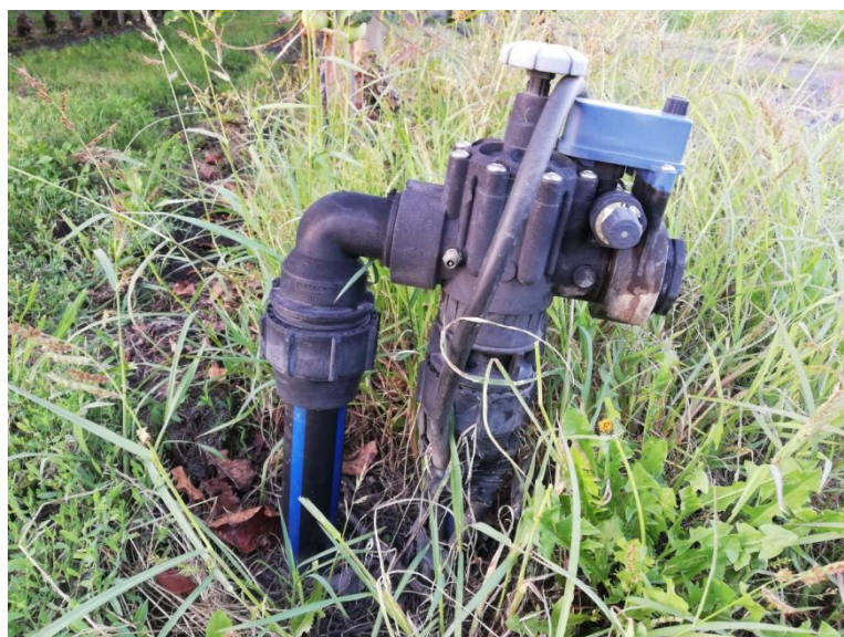
Slika 9: Razvodna stanica na koju se spaja polietilenska cijev za navodnjavanje izvor: Mirna Škoro (2019.)
