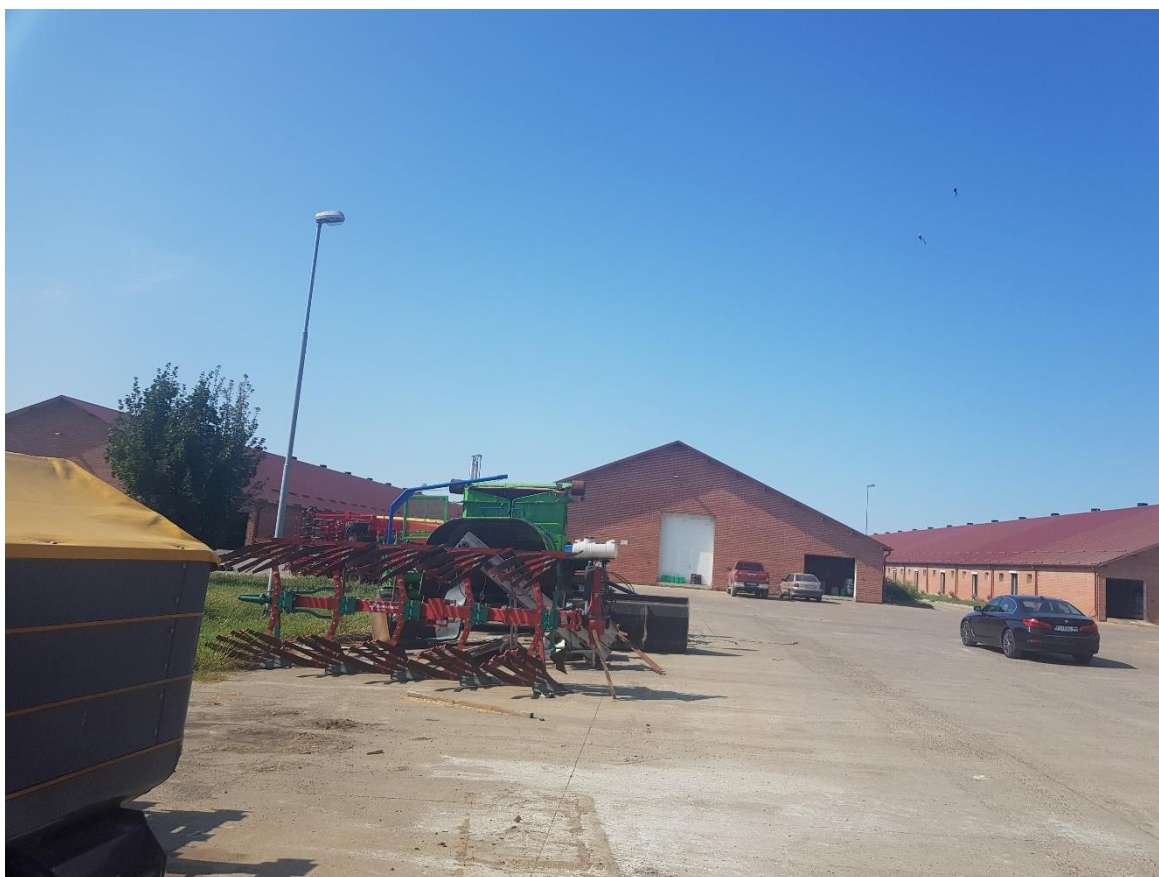
Slika 11. Proizvodni objekti farme za uzgoj teladi Simental Commerce d.o.o.
