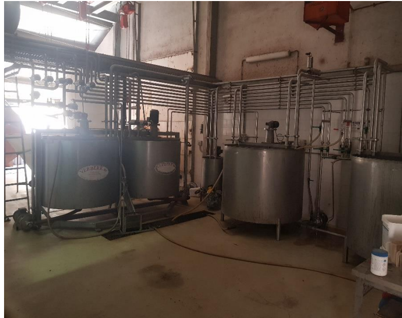
Slika 6. Centralna kuhinja u staji broj 2
