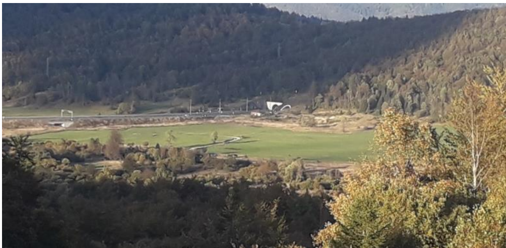
Slika 8. Dionica autoceste A6 kroz lovište Petehovac (Foto: T. Drenjančević)
