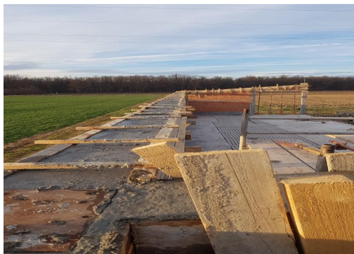
Slika 14. Gradnja objekta za tov junadi
