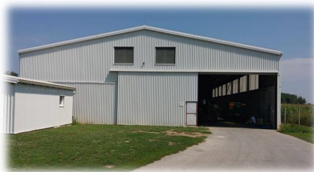
Slika 3. Skladišni silos OPG-a Dragan Čolaković
