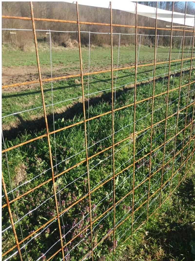
Slika 10. Ograda od armaturne mreže i pletene žice (Foto: Tihana Dročić)
