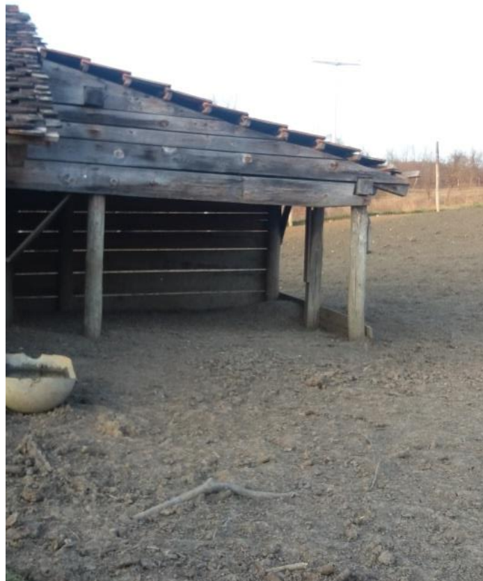
Slika 11. Nadstrešnica za sklonište od nepovoljnih prilika s pojilištem za jelene lopatare
