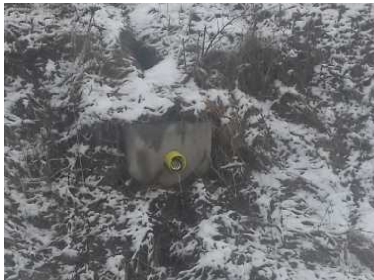
Slika 10. Prikaz istjecanja vode cijevnom drenažom (Izvor: Vlastita fotografija)
