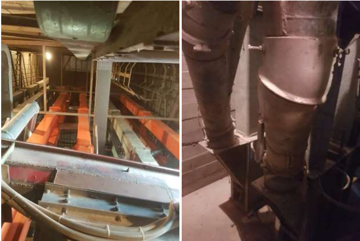
Slika 41. Elevatorske cijevi (lijevo) i stopalo (desno)
