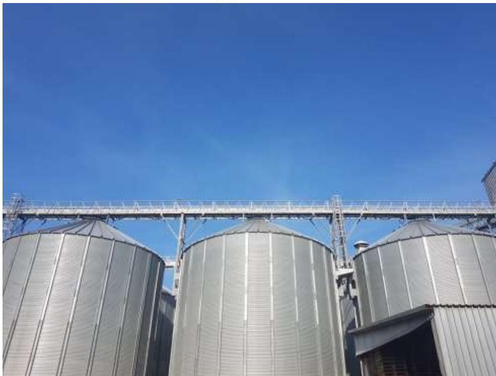
Slika 33. Lančani transporter u oklopu Redler na gornjoj galeriji za punjenje silo komora (Izvor: Lukačević, M.)
