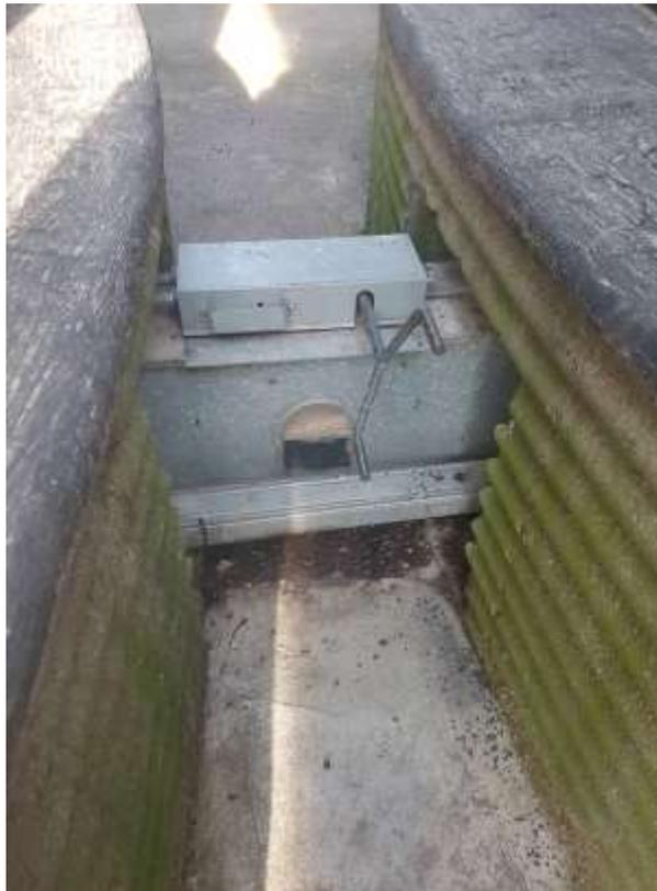
Slika 34. Zasun lančanog transportera u oklopu Redler za pražnjenje silo komora
