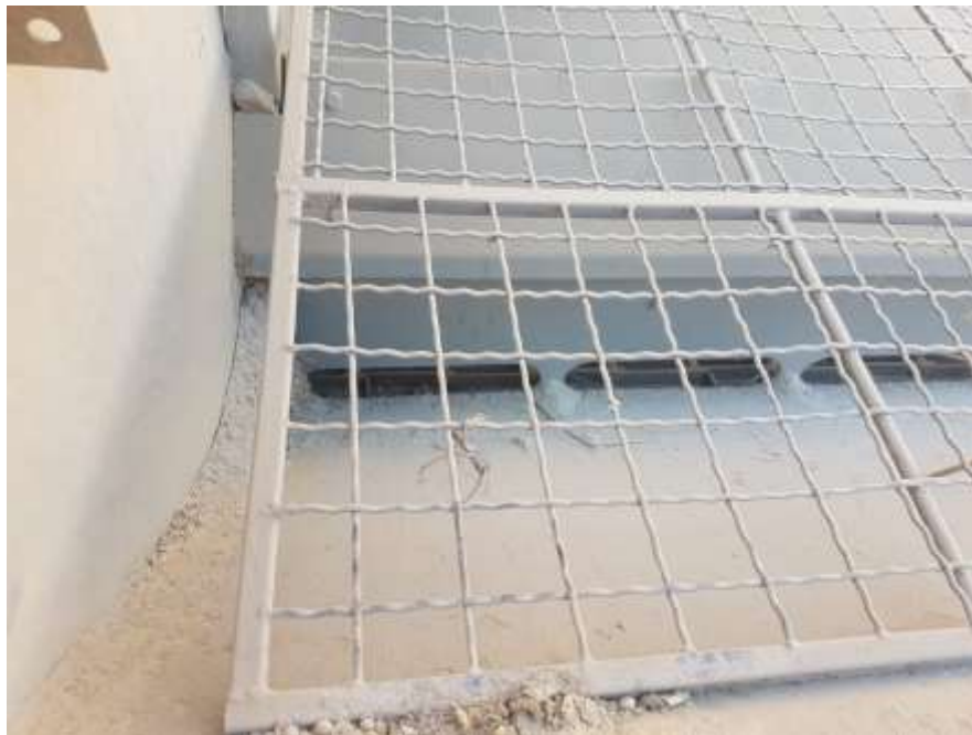
Slika 13. Mali usipni koš (slika gore) s lančanim transporterom u podnožju (slika dolje)
