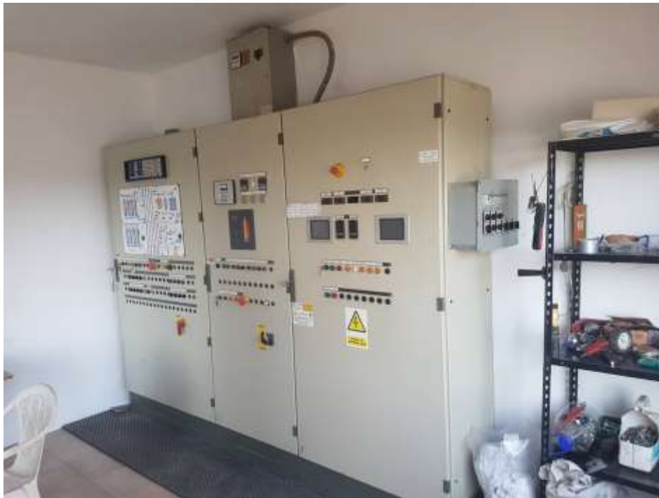
Slika 10. Upravljačko-rasklopní ormar
