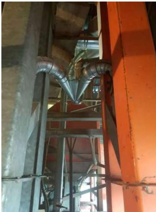
Slika 16. Mjesto spajanja cjevovoda i elevatorskih cijevi
