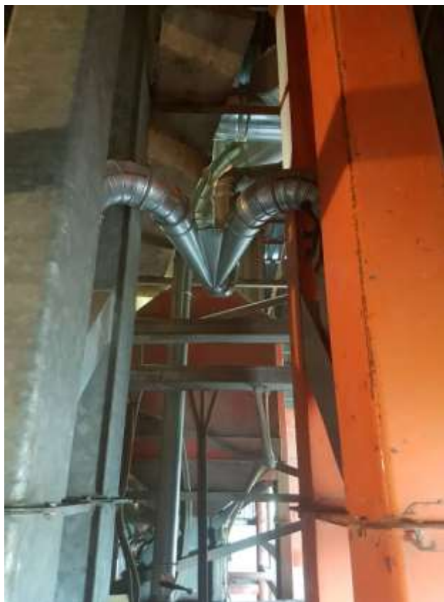
Slika 16. Mjesto spajanja cjevovoda i elevatorskih cijevi (Izvor: Lukačević, M.)
