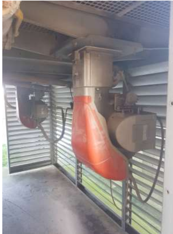
Slika 8. Plamenici Strahl sušara (Izvor: Lukačević, M.)
