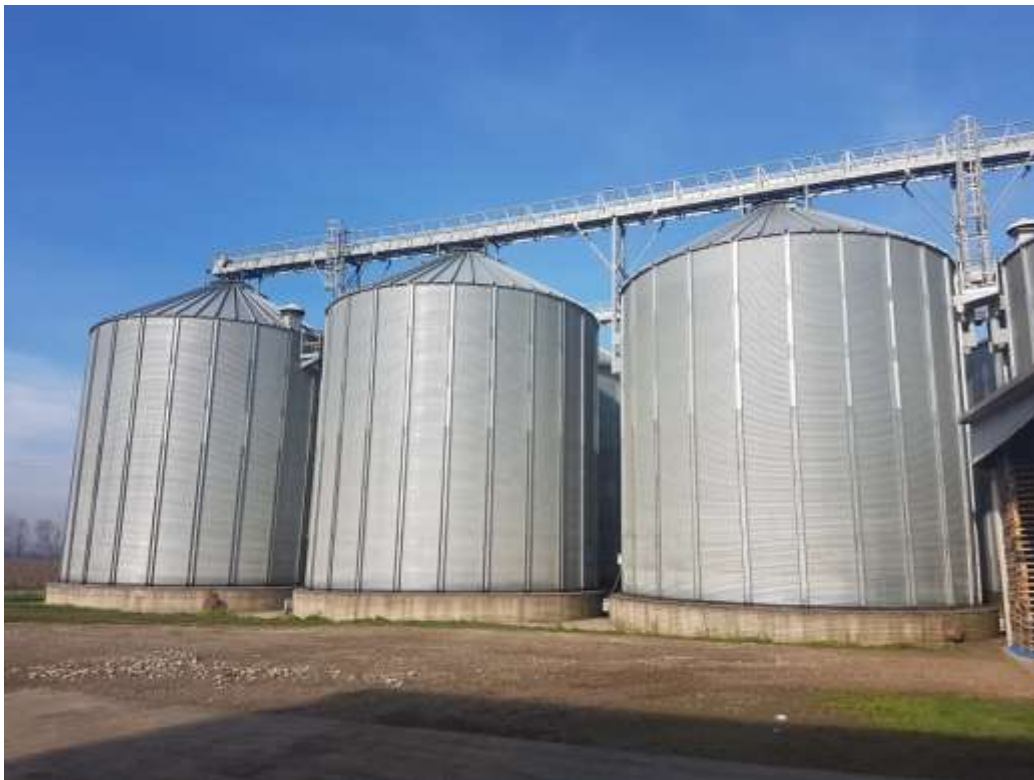
Slika 4. Silo komore (Izvor: Lukačević, M.)
