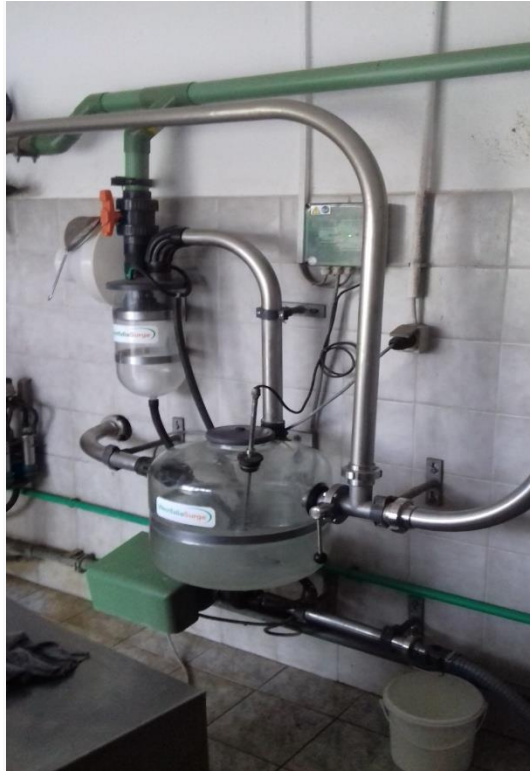
Slika 6. Prihvatna komora i sanitarni čvor
