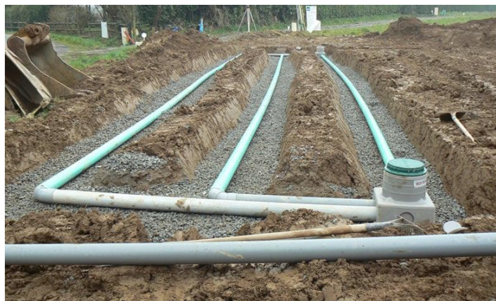
Slika 9. Prikaz sustava za drenažu
